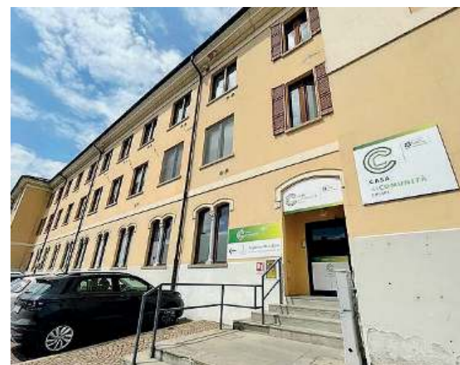
Sul territorio. Servizi di prossimità nelle Case di comunità
